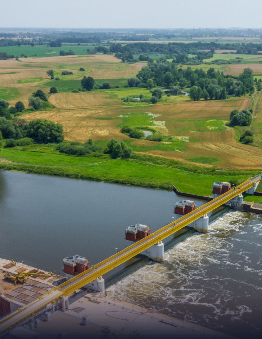
ELEKTROWNIA WODNA Lipki
